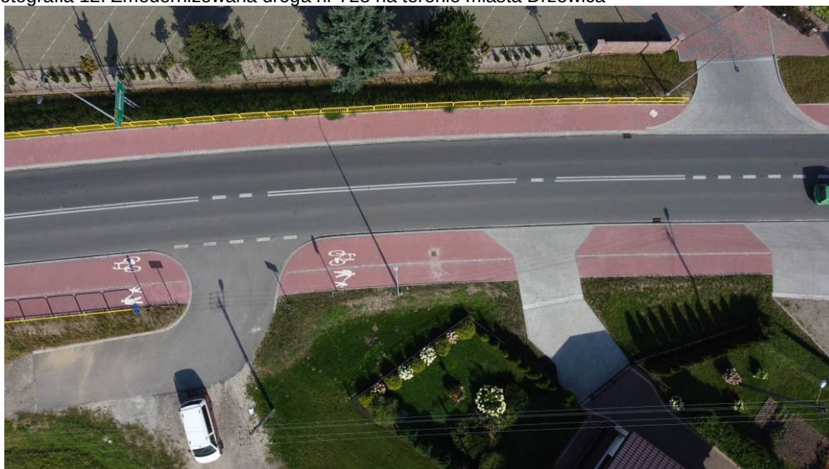
Fotografia 12. Zmodernizowana droga nr 728 na terenie miasta Drzewica
