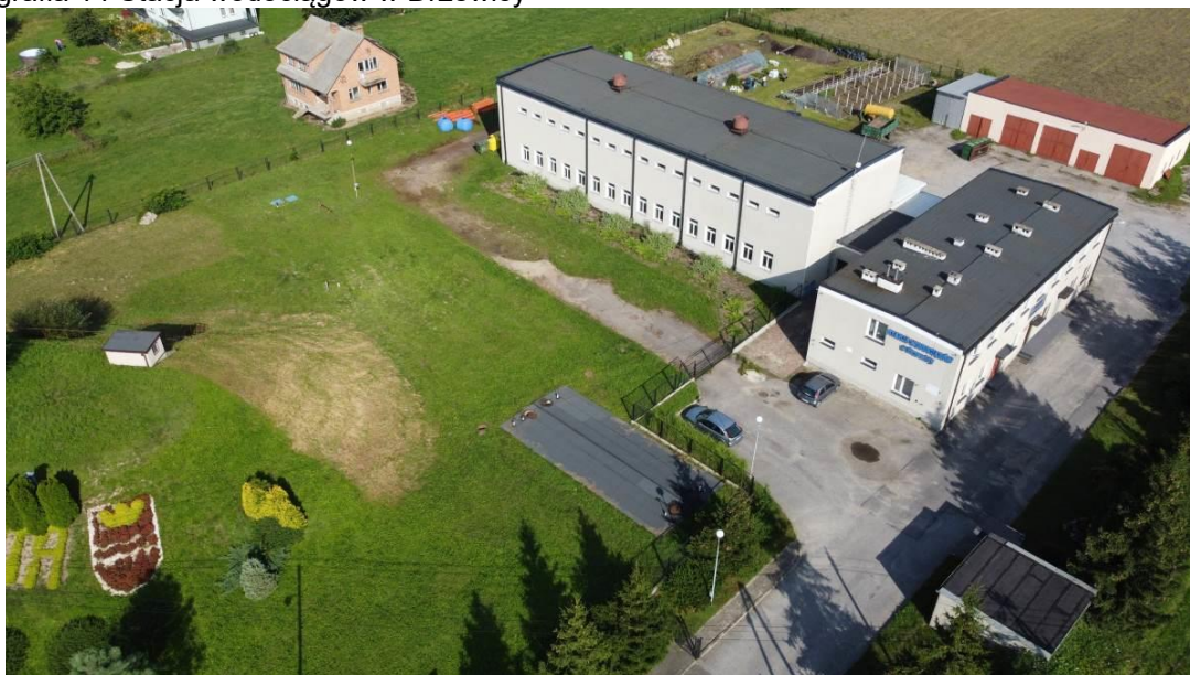
Fotografia 14 Stacja wodociągów w Drzewicy
